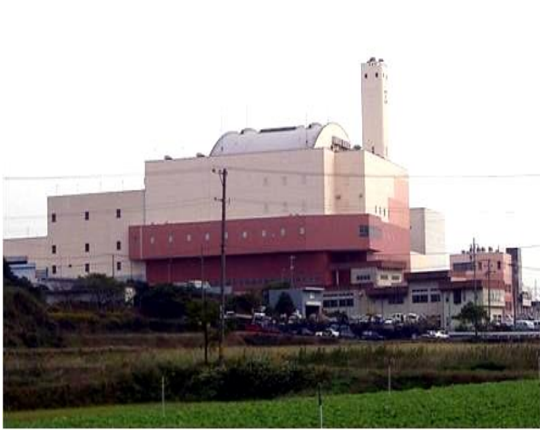
MES R21 plant Toyahashi
