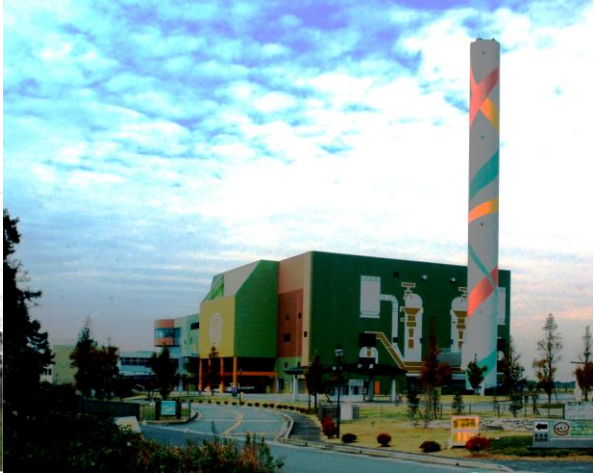
MES R21 plant Koga
