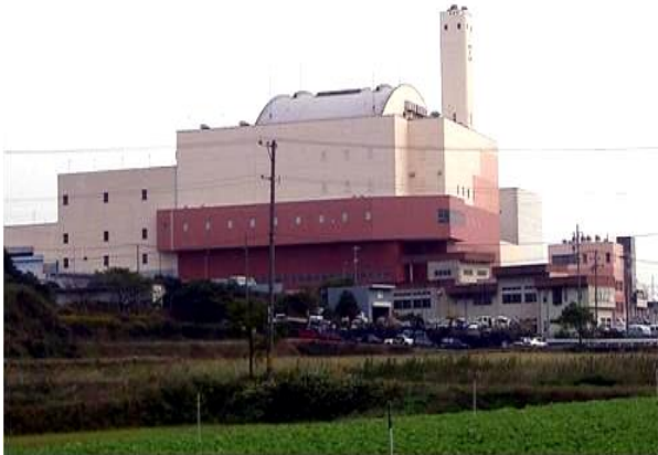
MES R21 plant Toyahashi
